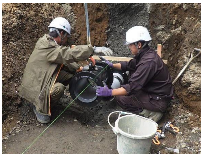
下水道本管布設工事
