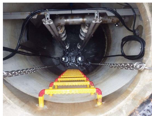
中継マンホールポンプ場の 設備更新工事
