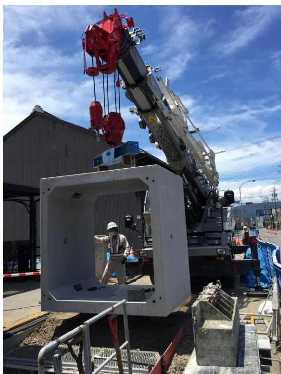
雨水渠布設工事 (大社通り四つ角付近)
