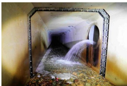
雨水渠の内部
