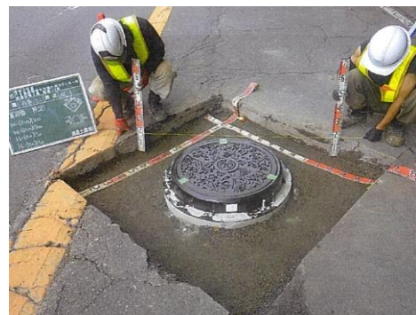
下水道長寿命化対策に伴う マンホール蓋取替工事
